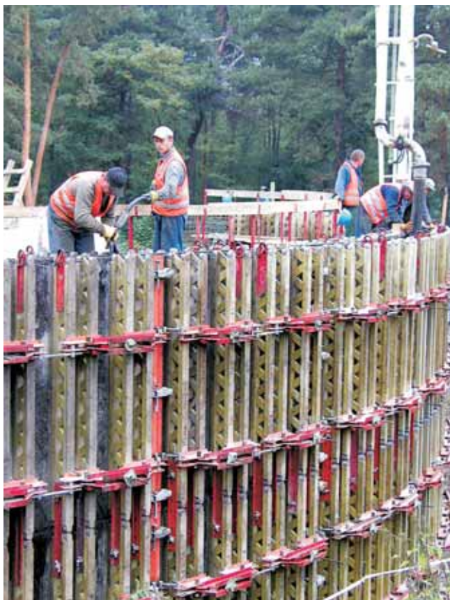
Betonowanie ściany zewnętrznej reaktora oczyszczalni ścieków
