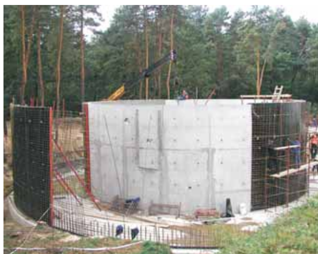
Zaawansowanie prac przy wykonywaniu reaktora oczyszczalni ścieków
