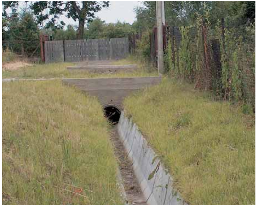
Rów odwadniający na zachód od ul. Przejazd
