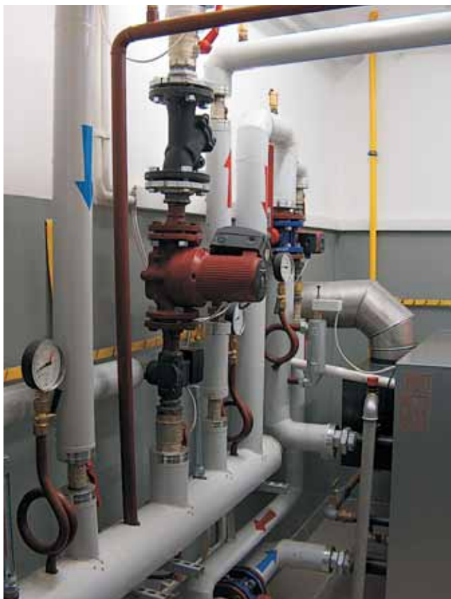
Modernizacja kotłowni w Przychodni Miejskiej Nr 2
