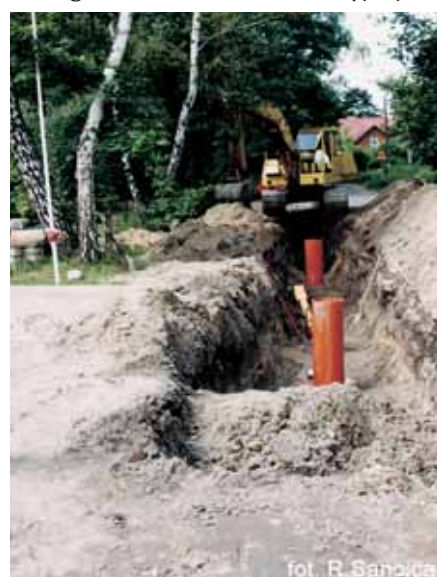
Budowa kanalizacji w ulicy 11-go Listopada
