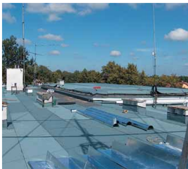
Modernizacja dachu na budynku Zespołu Szkół Licealnych
