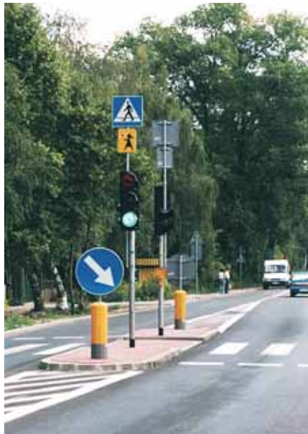
Przejścia dla pieszych przy szkole na ul. Okuniewskiej
