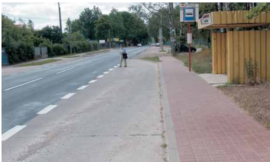
Ulica Okuniewska. Zatoka autobusowa przy skrzyżowaniu z ulicą Ogińskiego
