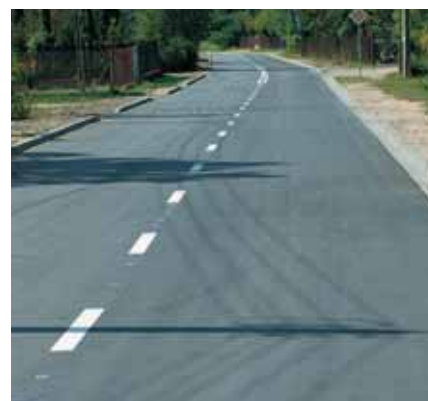
Budowa ul. Sobieskiego
