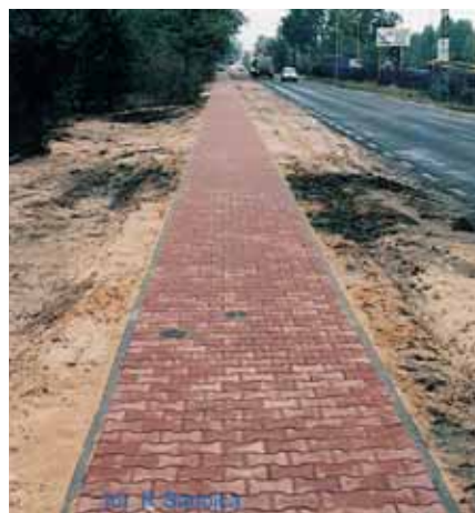
Chodnik do cmentarza wzdłuż ul. Piłsudskiego
